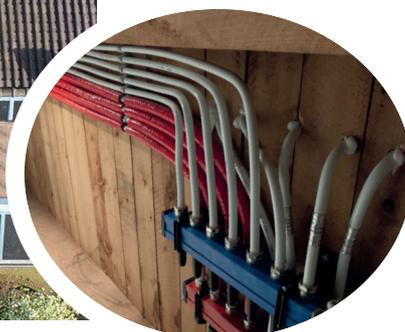
**STROM UND WÄRME** vom Dach wird in verschiedenen Kreisen zum Haustechnikraum geführt.
