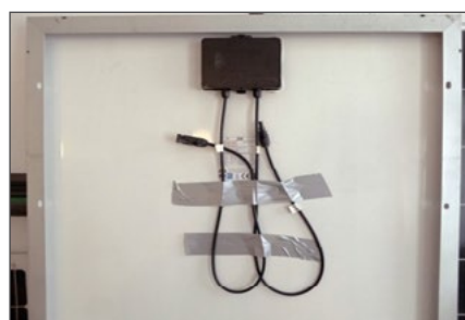
Bild 1 und Bild 2: Mit Klebeband fixierte Modulkabel
