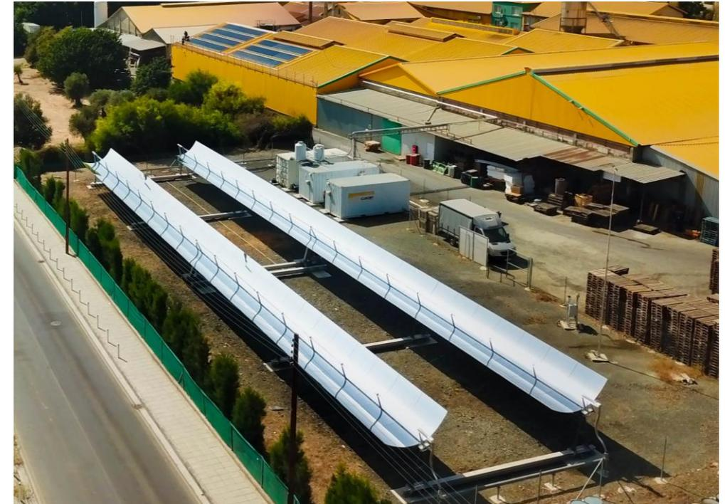
Parabolrinnenkollektor der Firma Protarget, Köln (Foto: Protarget)
